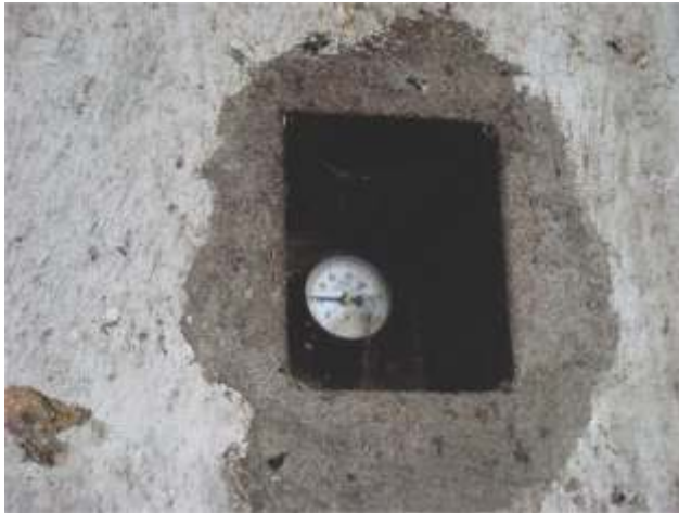
Termômetro instalado em secador
