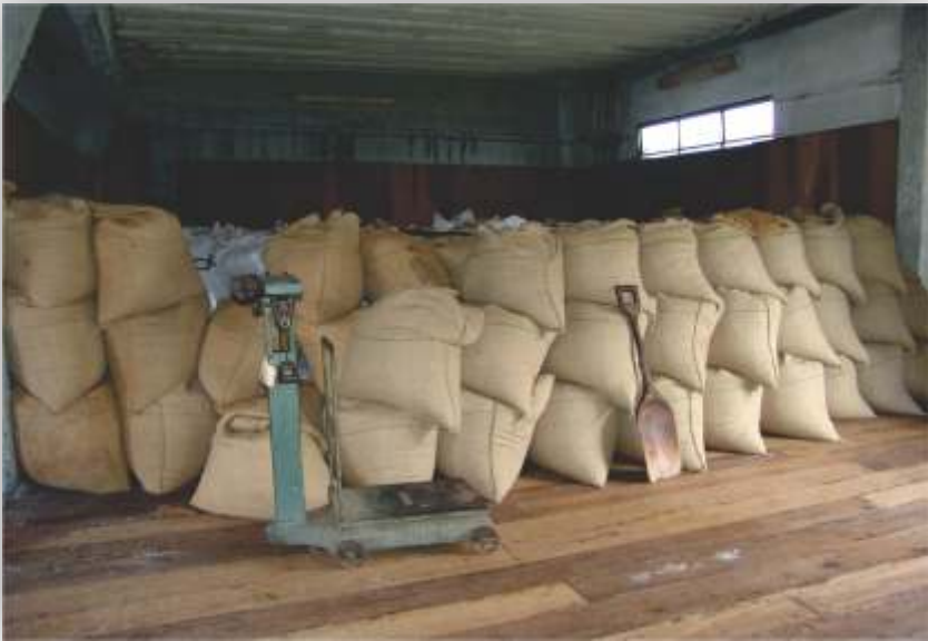
Armazém de cacau, com piso e revestimento de paredes com madeira
